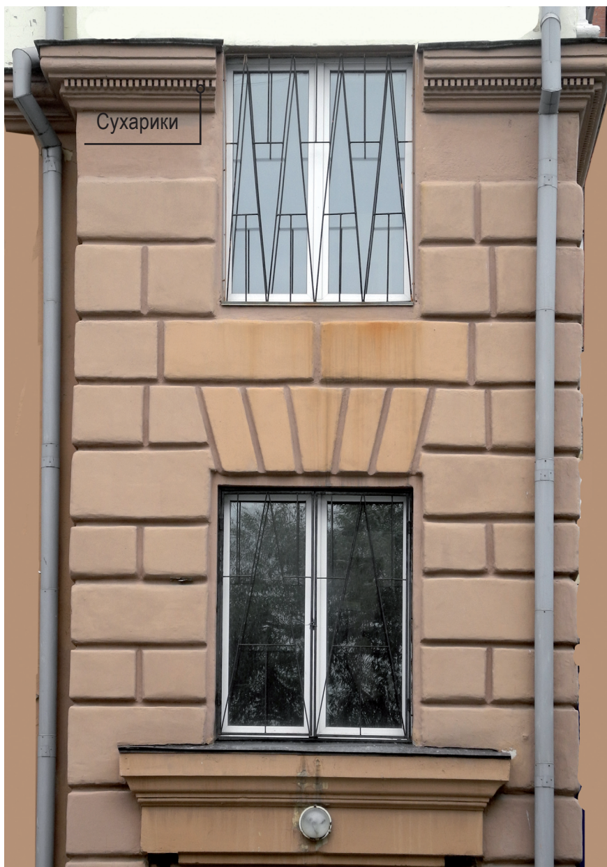
Фрагмент ризалита с рустовкой и веерным замком
