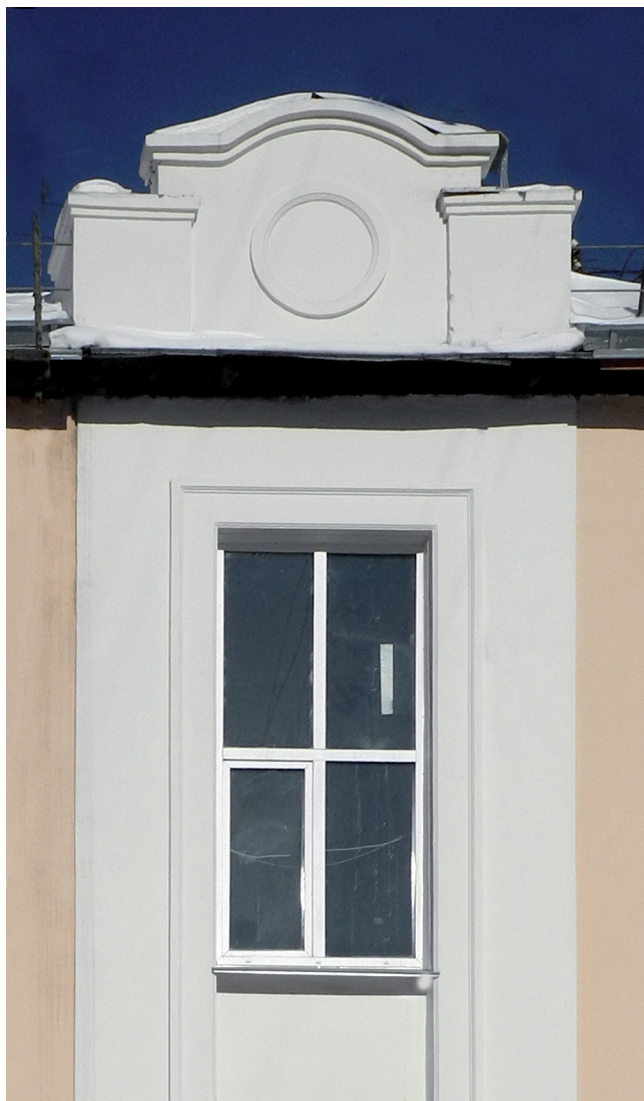
Аттик и фрагмент наружного оформления лестничного марша
