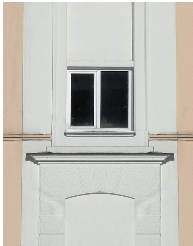
Фрагмент наружного оформления лестничного марша и портала
