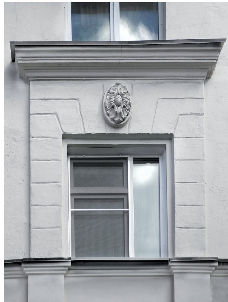
Обрамление оконного проема
