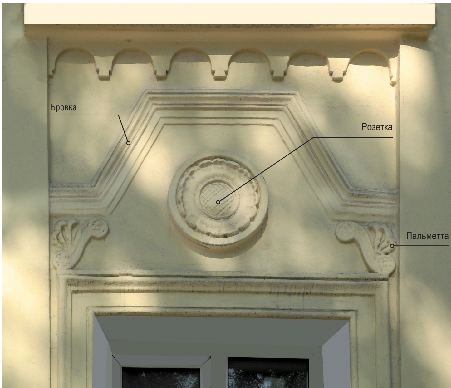
Оформление оконного проема
