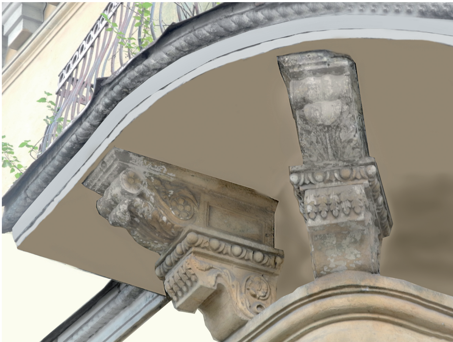
Кронштейны под балконом
