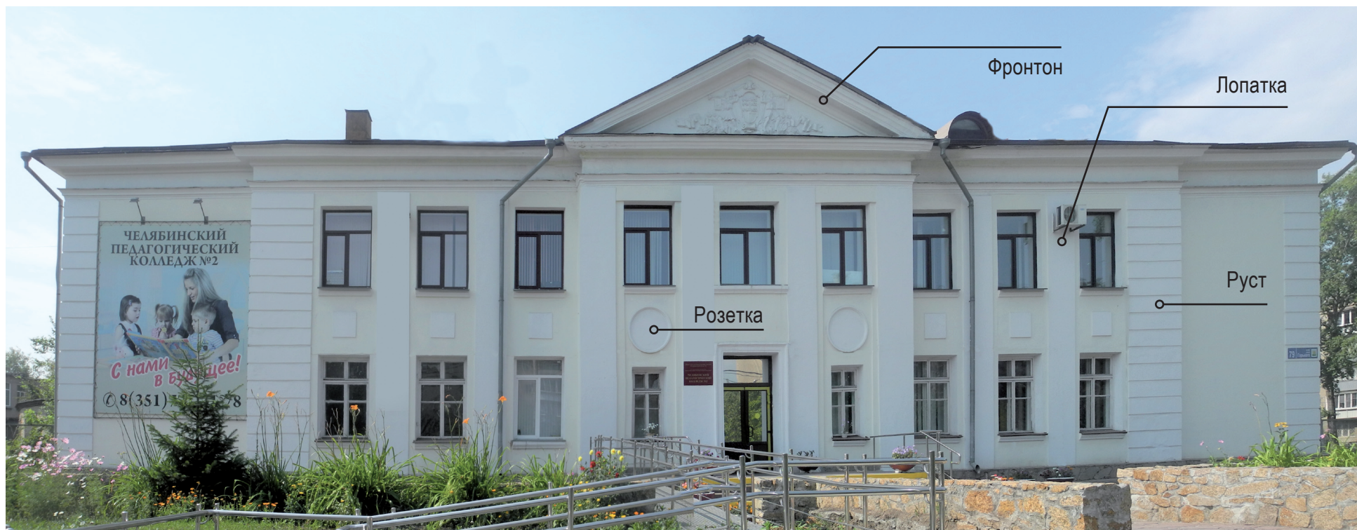
2-этажное здание ГБПОУ «Челябинский педагогический колледж № 2». Типовое 2-этажное здание начальной школы на 400 учащихся. Архитектор Н. М. Вавировский
