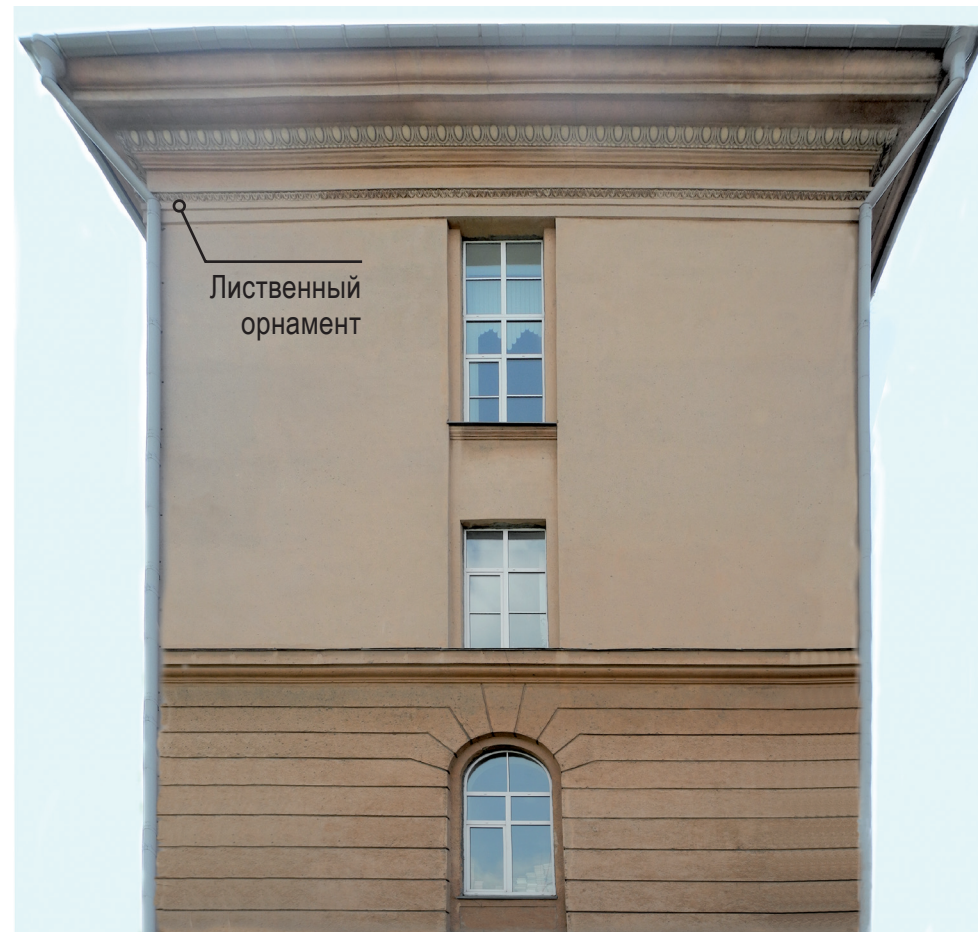
Ризалит северного фасада
