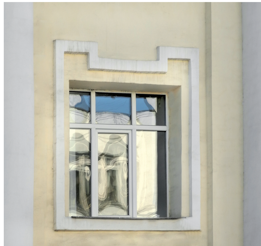
Оформление оконного проема
