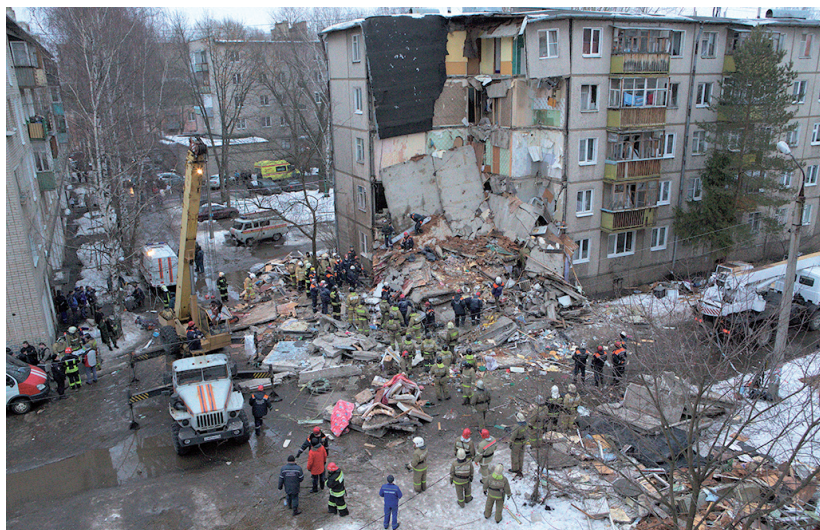
Рис. 4.6. Обрушение жилых домов от взрыва бытового газа в Волгограде 20.12.2015 года и в Ярославле 16.02.2016 года
