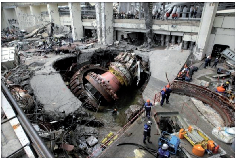
Рис. 4.8. Авария на Саяно-Шушенской ГЭС 17.08.2009 года
