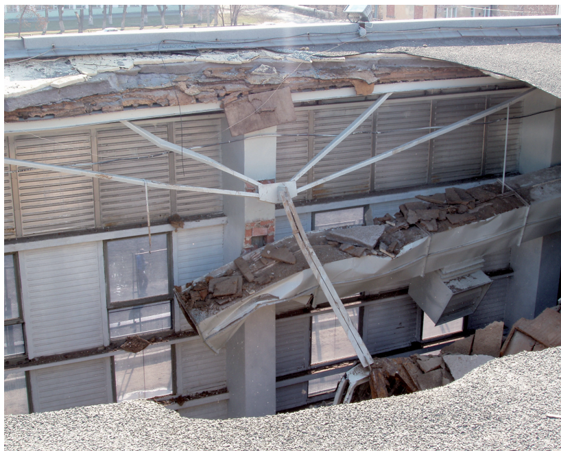
Рис. 5.12. Поврежденные металлоконструкции
