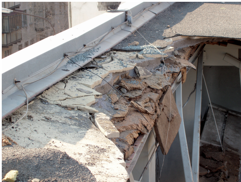
Рис. 5.13. Структура кровельного покрытия
