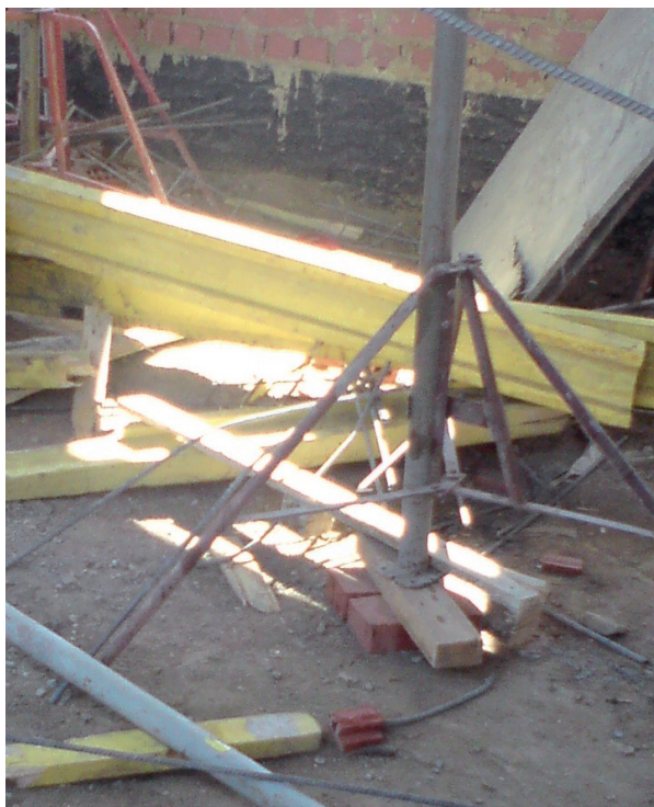
Рис. 5.16. Место установки стойки
