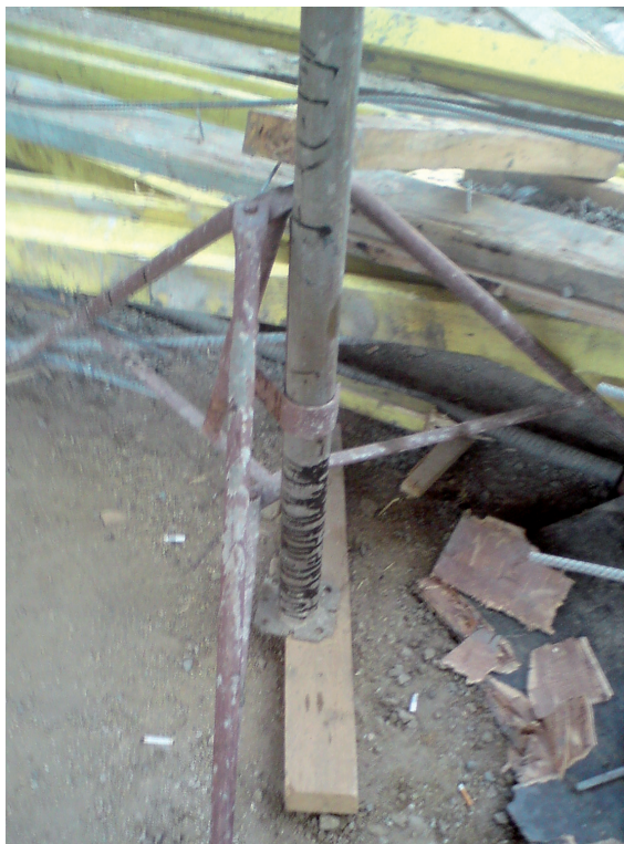
Рис. 5.17. Место установки стойки
