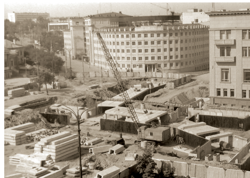
Строительство подземного пешеходного перехода на перекрестке улиц Кирова, Воровского и пр. Ленина
