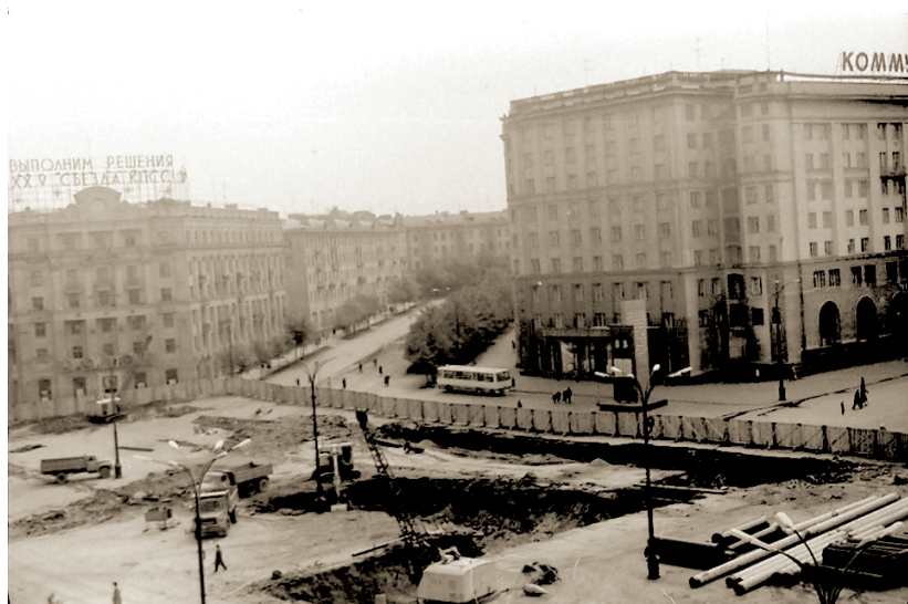
Строительство подземного пешеходного перехода на перекрестке улицы Цвиллинга и пр. Ленина
