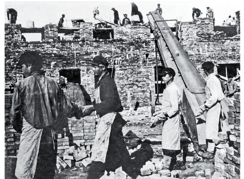
Механизация строительства на ул. Спартака
