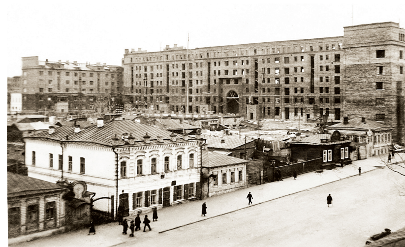
Челябинск. Строительство семиэтажного жилого дома, фасад которого обращен к площади Революции. 1937 г.
