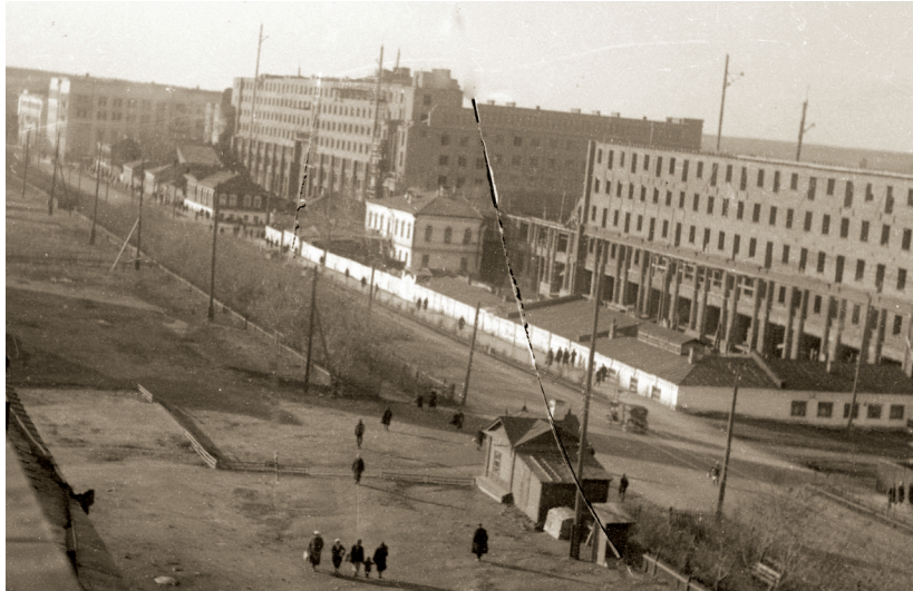
Знакомый пейзаж с видом на строящийся Дом на площади
