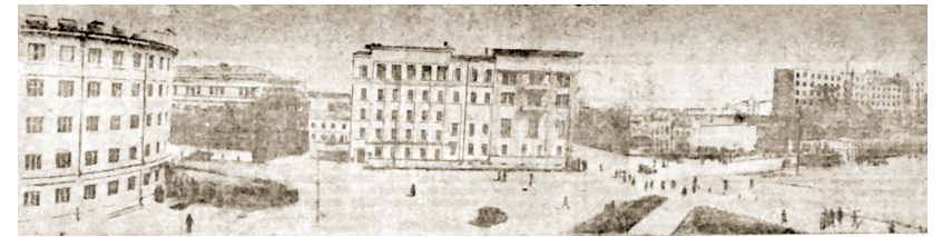
НОВЫЙ ЧЕЛЯБИНСК. Центральная часть нашего города изменяет свой первоначальный вид. Вместо одноэтажных, двухэтажных домов построены и строятся 5—6-этажные здания. На нашем снимке группа новых зданий, выстроенных за два последних года по улицам Спартак и Кирова, Слева направо — гостиница, здание Государственного банка, обком ВКП(б) и строящийся жилой дом облисполкома. Фото: В. Тишечкина («Сталинская смена», 02.08.1936 г.)
